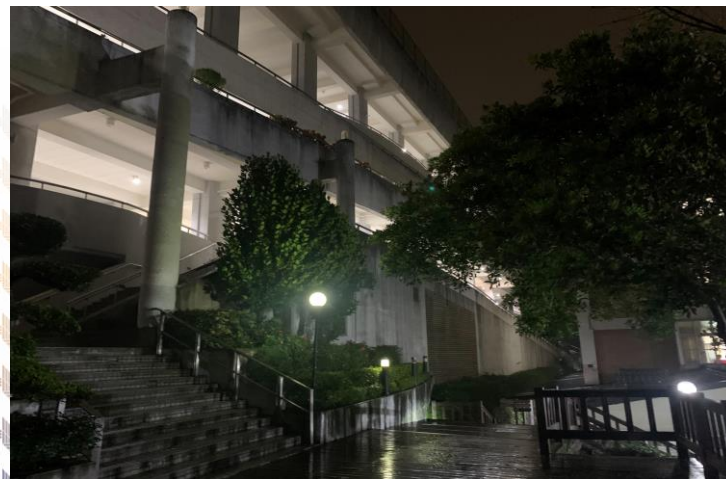
U棟夜間-燈光改善
