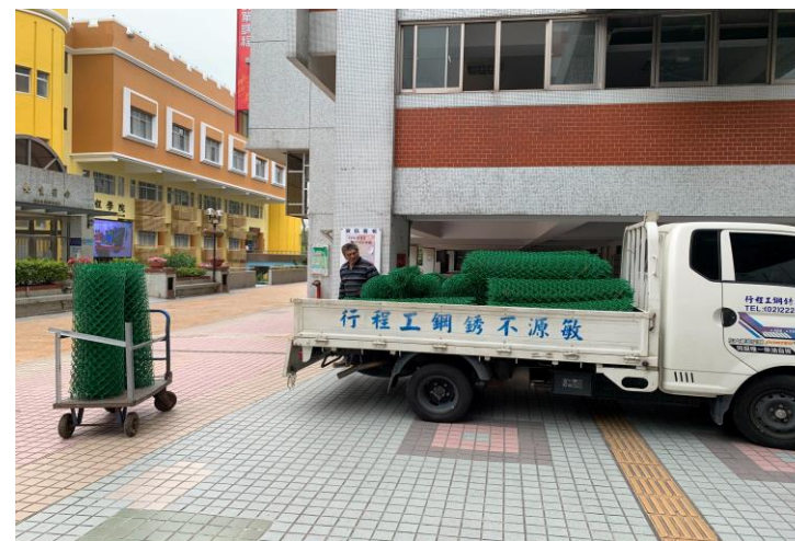
防墜網安裝準備
