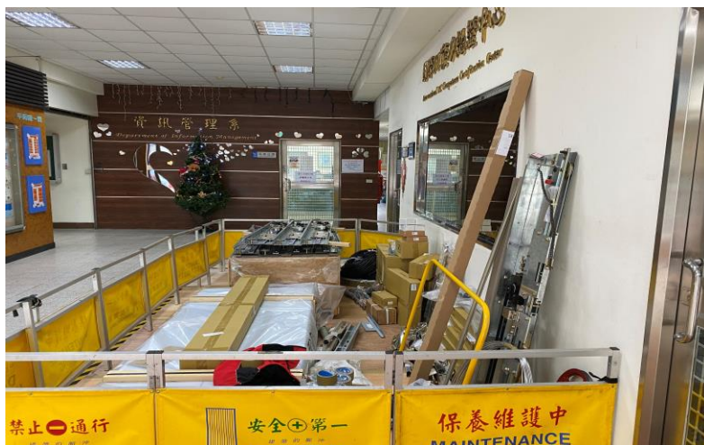
資訊系-施工圍籬標示
